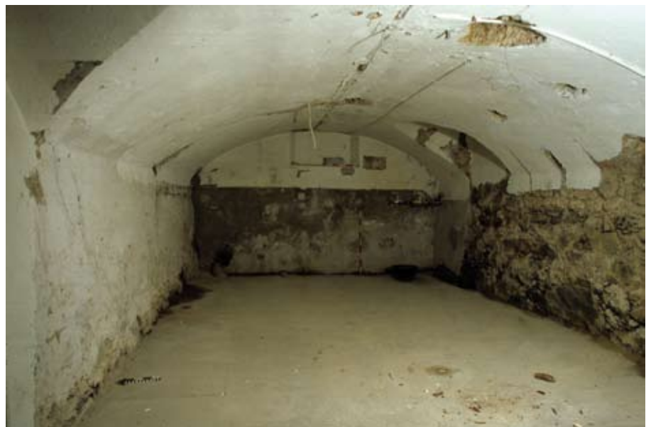
Abb. 7. Der gewölbte Kellerraum im Südosten des Hauses, Blick nach Osten.
