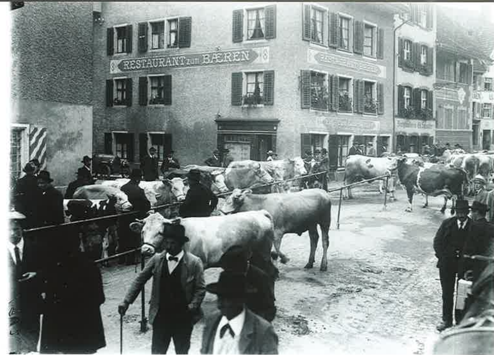
1 Zeughausplatz mit Viehmarkt vor dem Restaurant Bären. Am linken Bildrand das Zeughaus (ehemaliges Kornhaus).
